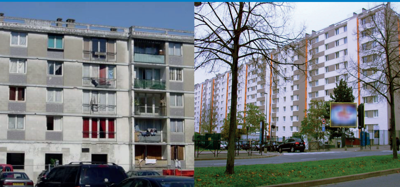
▲ Copropriété concernée, avant travaux puis après travaux
