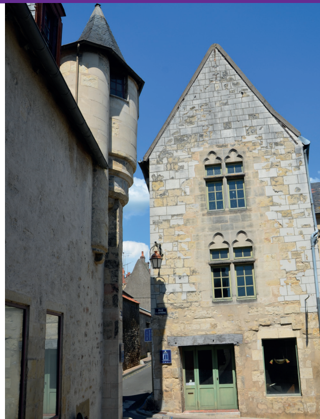
▲ Immeuble dans l'OPAH de Nevers
