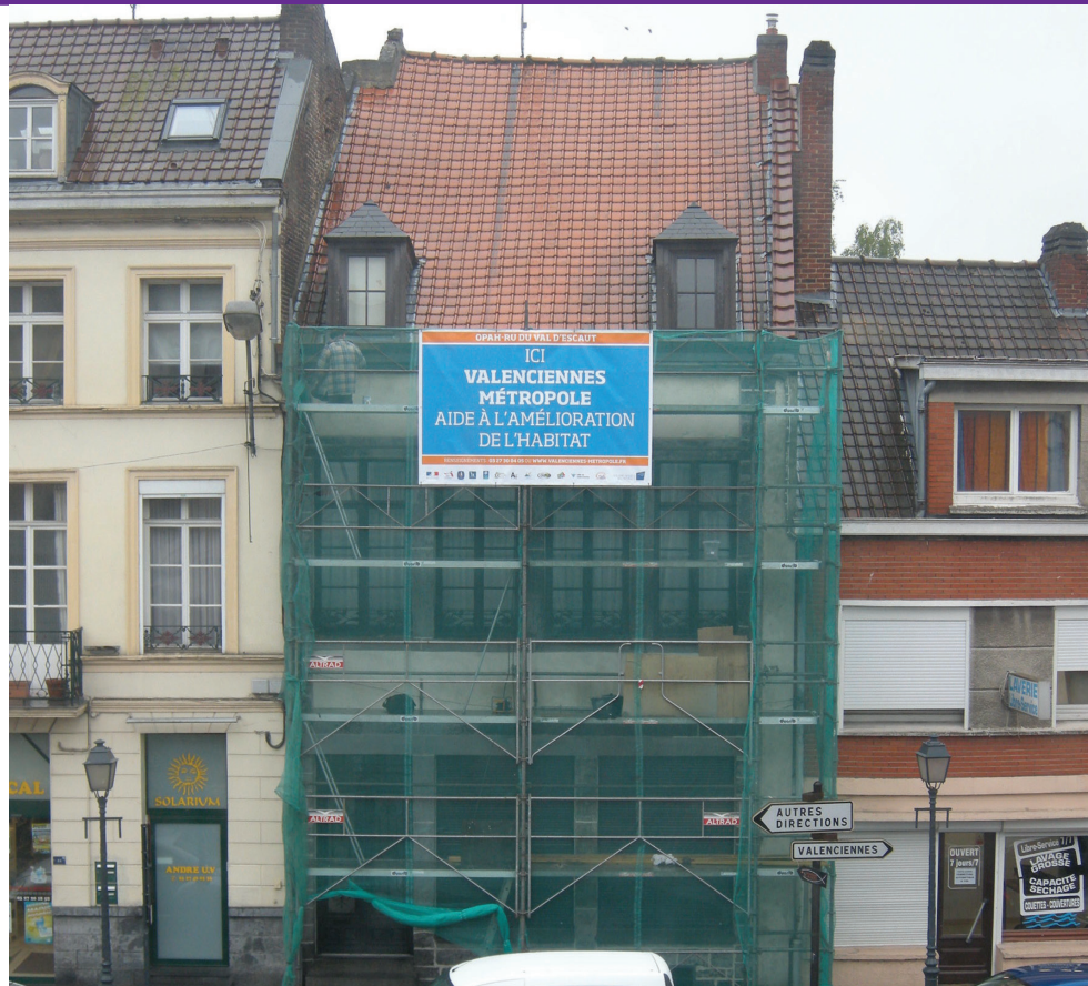
▲ Bâche posée sur l'immeuble 37 rue Delcourt à Odomez
