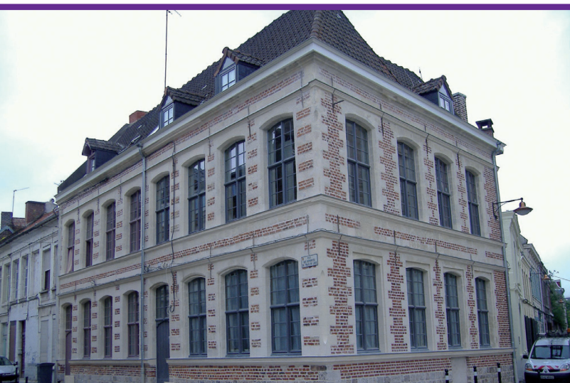
◀ Immeuble 120-120 bis rue des déportés à Valenciennes
