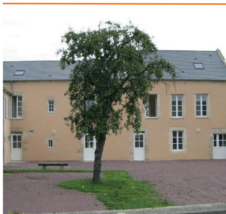
▲ Opération achevée : immeuble communal à Crépons
