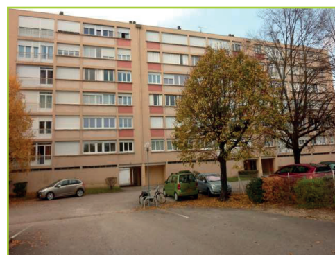
Copropriété Jean Thiébaud 10 Chemin de la Poudrière 36 logements
