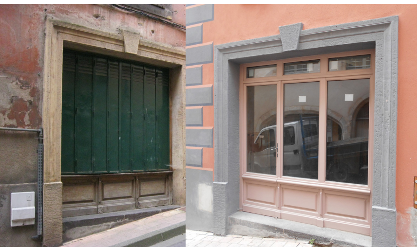
◀ Cellule commerciale rue Dumas avant et après travaux
