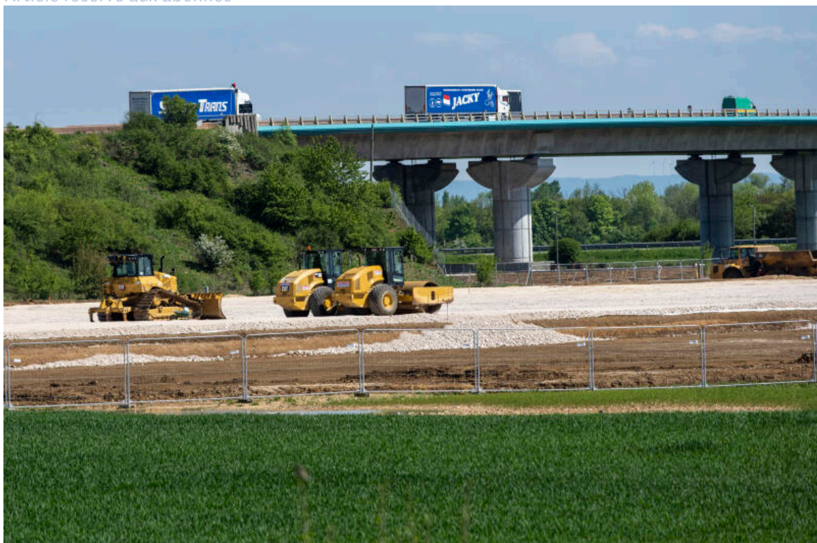
Chantier de construction d'une zone d'activité commerciale sur un ancien champ
