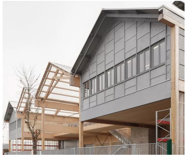
La Fabrique Cycle Terre, créée en novembre sous forme de coopérative par plusieurs entreprises et collectivités, transforme la terre crue des déblais de chantiers d'Île-de-France en matériaux de construction. Source: « Sevrans : la Fabrique Cycle Terre recycle les terres excavées du Grand Paris », Leo Da Veiga, Les Echos, 4 janvier 2022.
