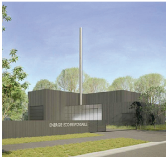
Chaufferie Biomasse des Aubiers - Domofrance.
